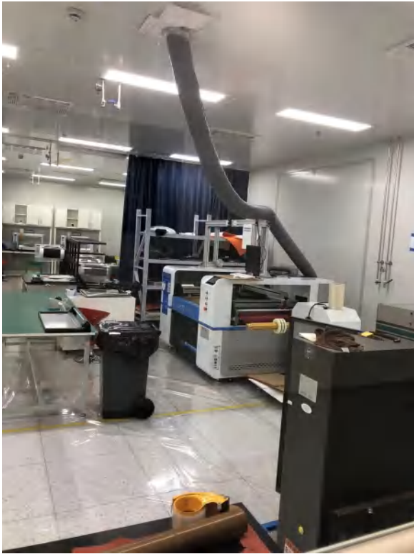
图 3-4 裁剪废气管道
